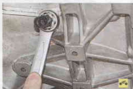
11. Ослабьте затяжку выключателя света заднего хода...
