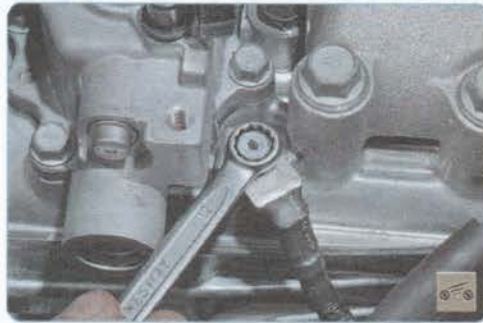
20. Выверните болт крепления наконечника провода «массы»...
